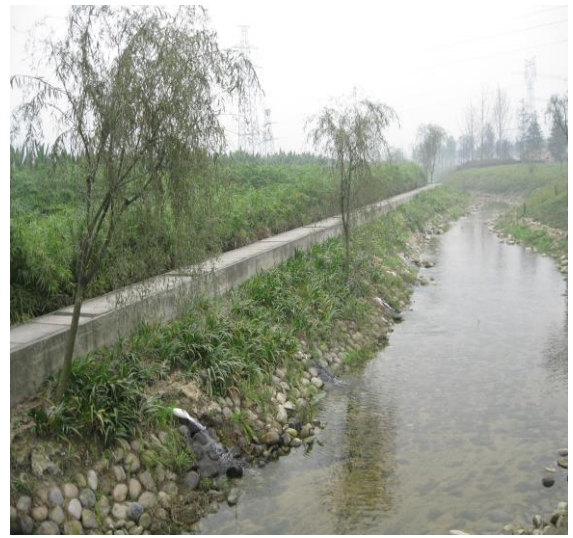
Hình 1.15. Hệ thống thu nước sau bãi lọc trồng cây
