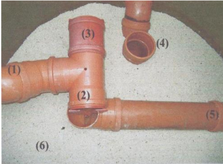
Hình 1.11. Hệ thống ống tuần hoàn
