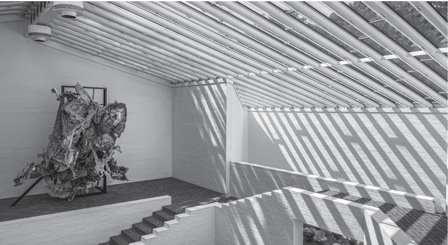
Hình 2.5. Hệ lam che nắng cho cửa kính trên bề mặt tường công trình (Nguồn: unsplash.com).
