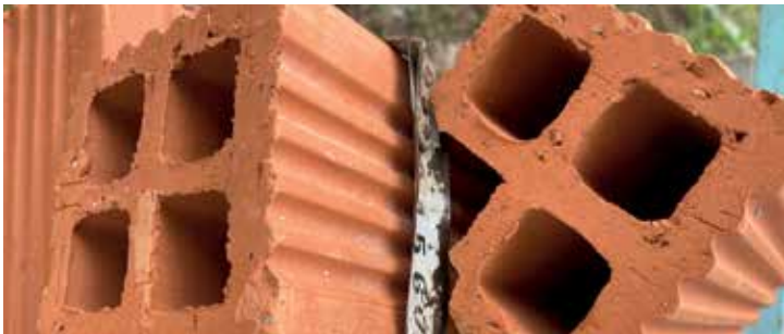
Hình 5.4. Các khoang rỗng chứa không khí trong công trình nâng cao hiệu quả cách nhiệt (Nguồn: Andreas Zegowitz)
