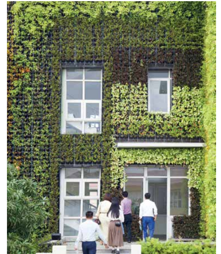
Hình 9.1b. Phủ xanh mái và mặt đứng được lựa chọn bởi khả năng hấp thụ nhiệt thấp, so với các vật liệu khác như bê tông hoặc tôn mạ (Nguồn: Ảnh trái: Michael Waibel, 2023; ảnh phải: © GIZ/Lương Thành Trung, 2023)
